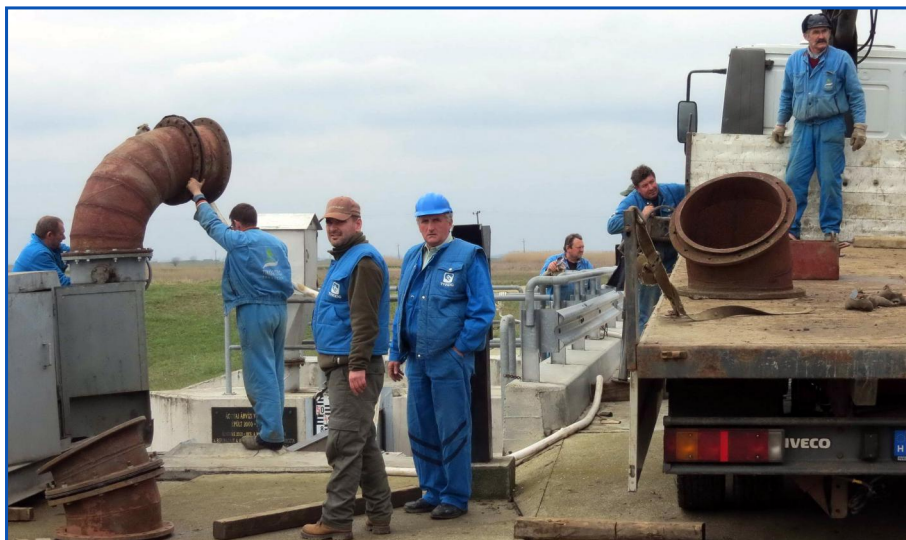
Szivattyúkat telepített az MBSZ Ágotán
