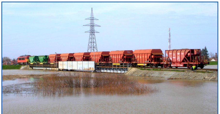
Szeghalom - Vésztő vasúti híd leterhelése vagonokkal
