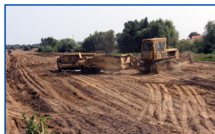
Bakonszeg térségében már építik az új töltésszakaszt
