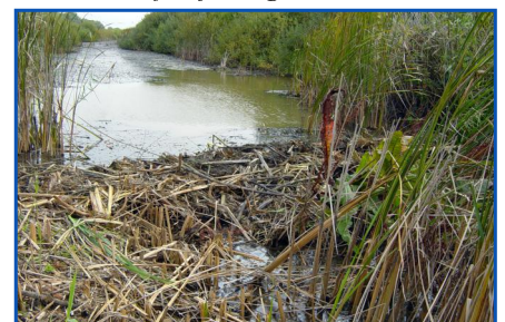
Hódgát a Tisza II szivárgó csatornán
