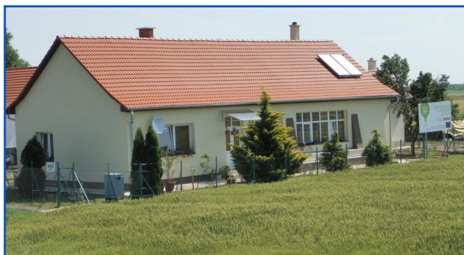
A felújított darvasi gátörház
