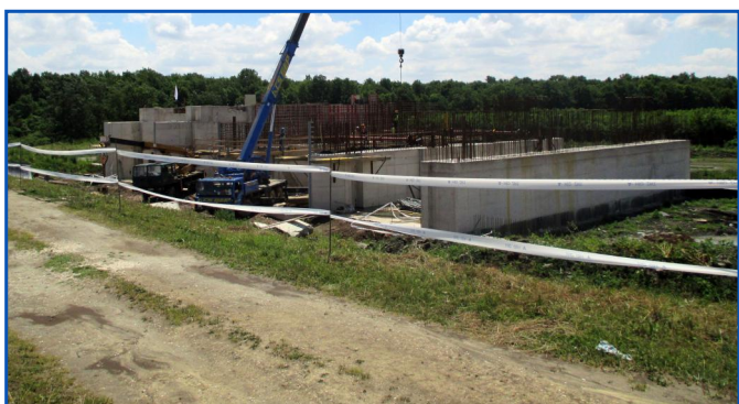
Fekete-Körös, Mályvádi tározó felső beeresztő építése
