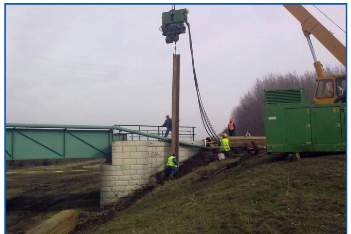
Berettyóújfalu - Berettyó híd átépítéséhez szükséges szádlemez verési munkák
