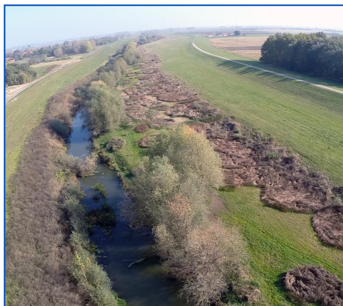
Szükséges a hullámtér rendezése
