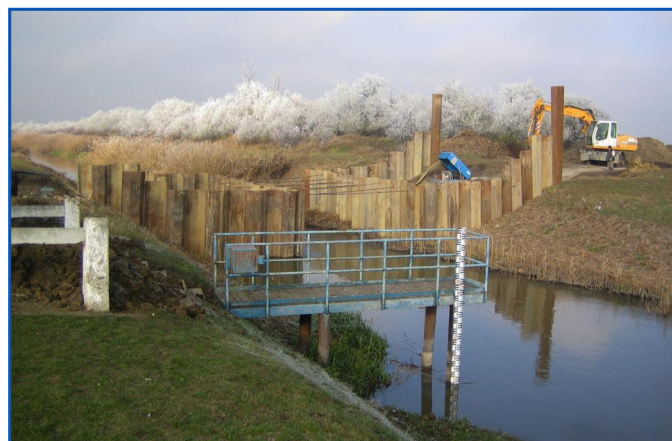
Kivitelezés közben a Kösely-állomás
