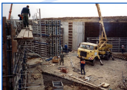
Épül a vész-elzáró mű
