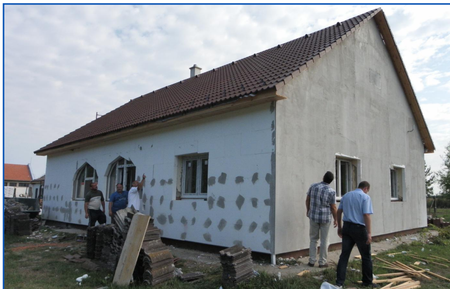
Tiszatarjáni gátórház felújítása
