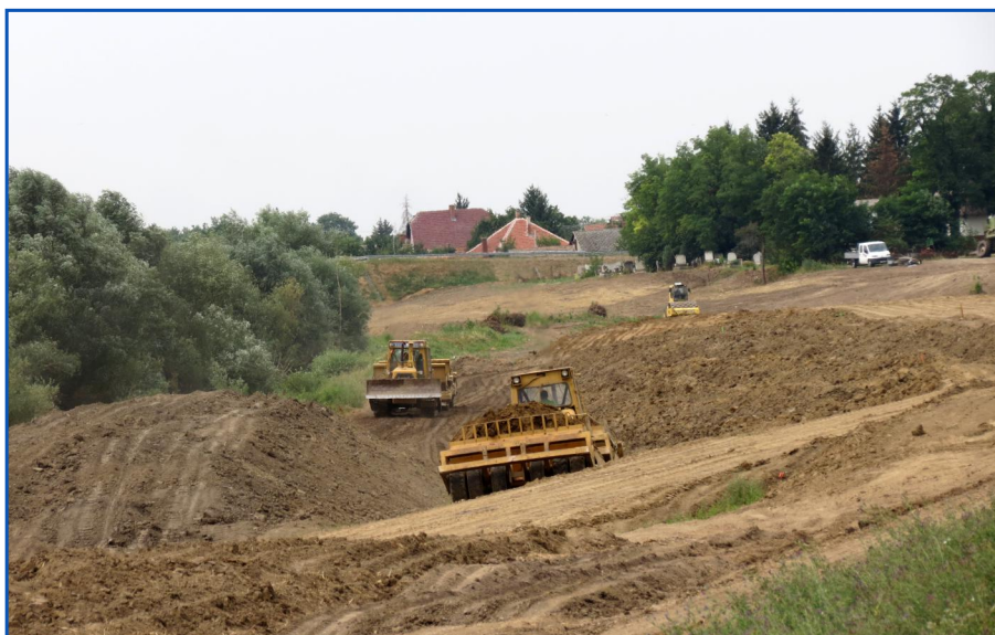
Új töltés építése Bakonszegnél
