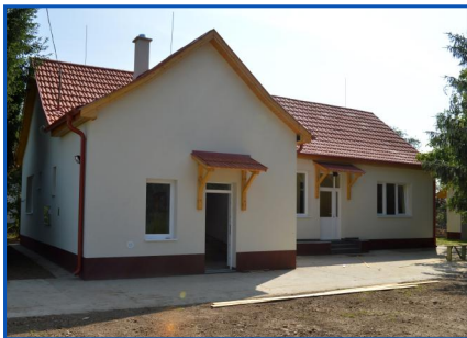
Felújított gátórház a Sebes-Körös mellett
