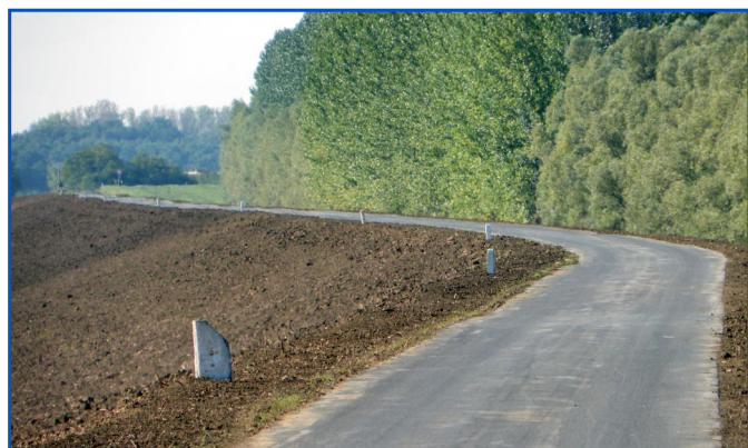
A teljesen átépített tiszagyulaházi töltésszakasz
