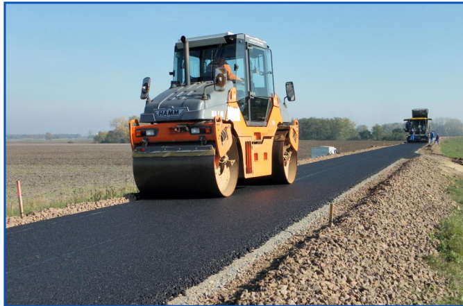
Épül az árvízvédelmi út
