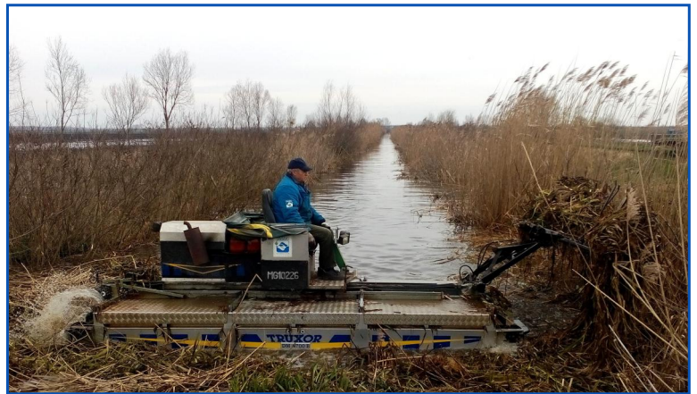
A Hortobágy-Kadarcs összekötő csatorna tisztítása Truxor munkagéppel
