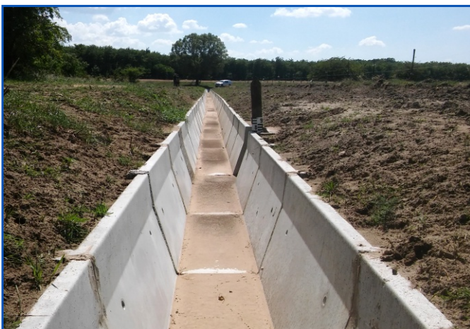
Mederburkolat helyreállítás a Fülöpi éren
