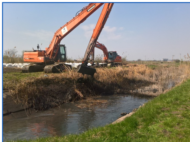
K-IX-főcsatorna kotrása
