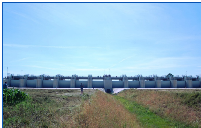
A 126 millió m 3 tározására alkalmas Szamos-Krasznaközi tározó beeresztő műtárgya
