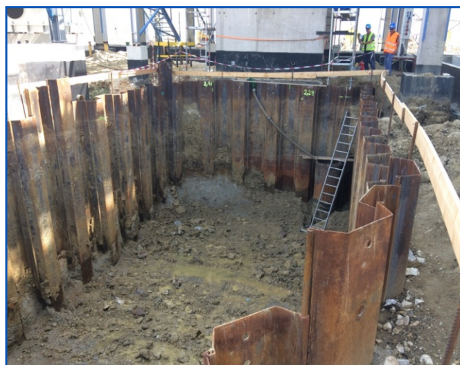
TVK-APS, UNIT 500 szeparátor akna szádlemezes dűcolása
