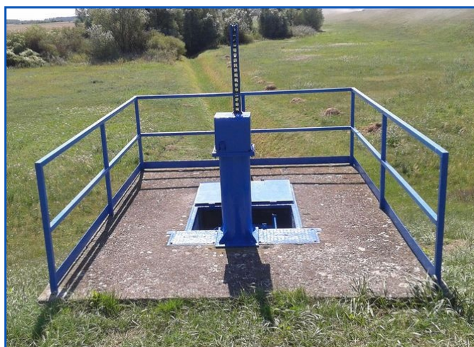
Ér-főcsatorna jobb part, Töviskesi zsilip
