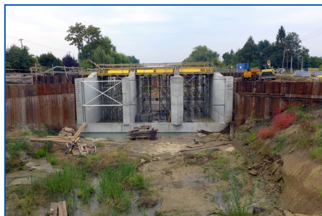
Új duzzasztó műtárgy építése Hajdúszoboszlónál
