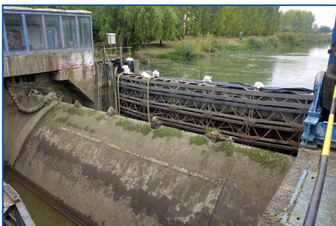
Balamzúvárosi bukó gépészeti felújítása
