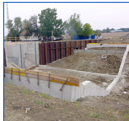
Új vízleadó zsilip építése Bakonszegnél
