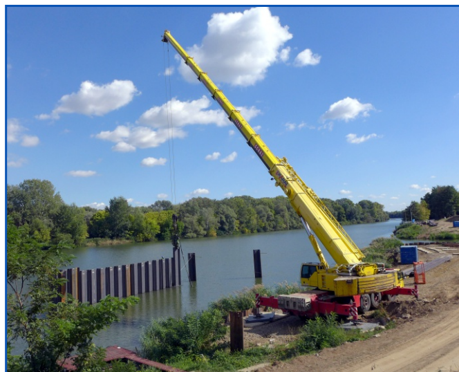
Hordalék és uszadékterelő építése a tiszai torkolatnál
