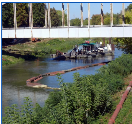
Torkolati szakasz kotrása úszókotróval - hidromechanizációs eljárással
