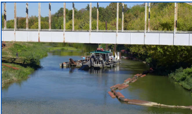
Úszó kotró dolgozik a főcsatorna torkolati szakaszán
