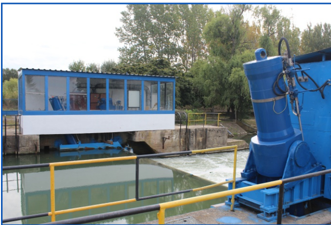
Az új és felújított hidraulikus mozgató berendezés a Balmazújvárosi bukónál
