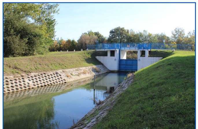
K-VII–Kösely vízkivételi műtárgy a felújítás után
