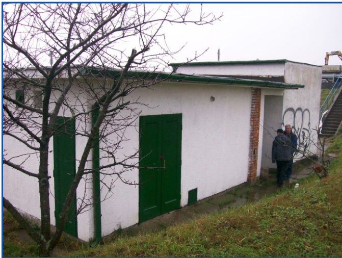
Kiskunlapos szivattyútelep kezelőépület
