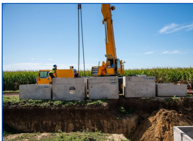
Vízkivételi műtárgyak beépítése
