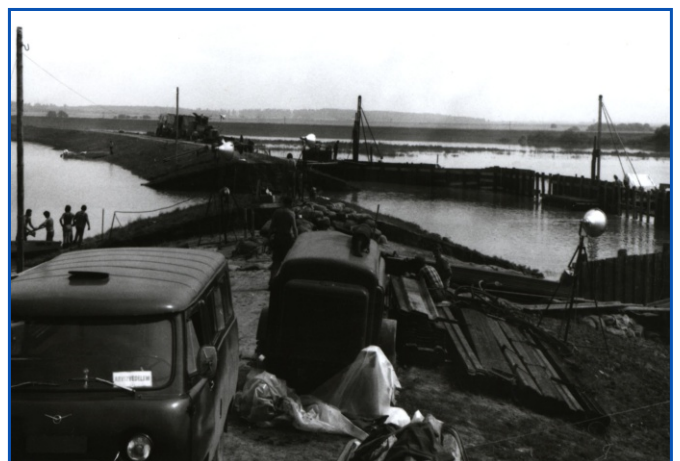
Készül a töltésszakadás ideiglenes elzárása
