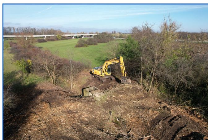
Munkaterület előkészítése műtárgyépítéshez a Tóció mentén
