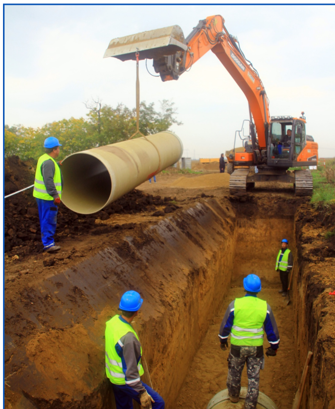
Vezetékfektetési munkák Debrecen közelében
